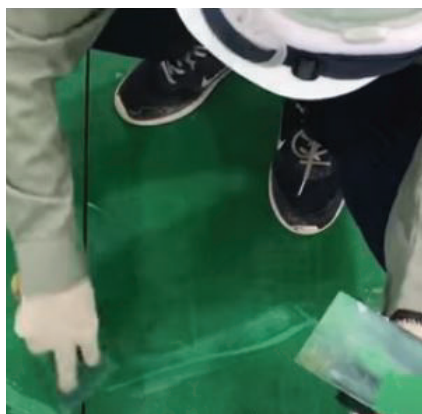
BẢ VỮA EPOXY VỚI VỠ RỖ LỚN Use epoxy mortar with large pits
